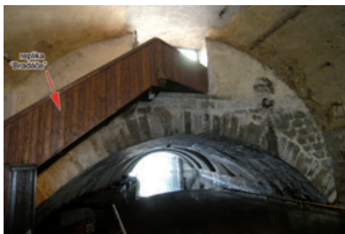
Obr. 2. Praha-Staré Město, Křižovnícké náměstí. Pohled na jižní stěnu bývalého Juditina mostu a průhled příslušným románským mostním obloukem. Šipka ukazuje na místo, kde je za dnešním dřevěným schodištěm v jižní stěně mostu zadržívka po kvádru s plastikou, vyjmutém v letech 1847–48. Prostor se nachází pod dnešním náměstím. (Pohled od jihu, foto J. Hlavatý, 2005.)
