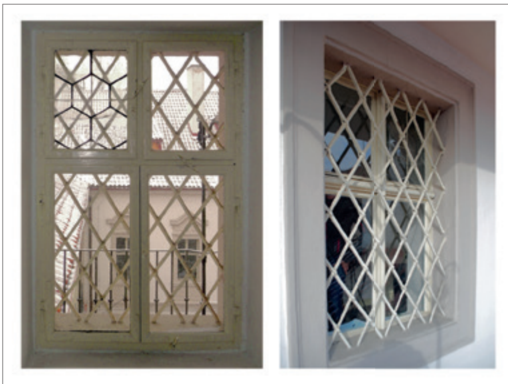
Obr. 2. A, B. Praha 1-Malá Strana, čp. 485, Velkopřevorský palác. Pohled na dokumentované okno z interiéru a exteriéru (foto V. Bartošová, 2012).
