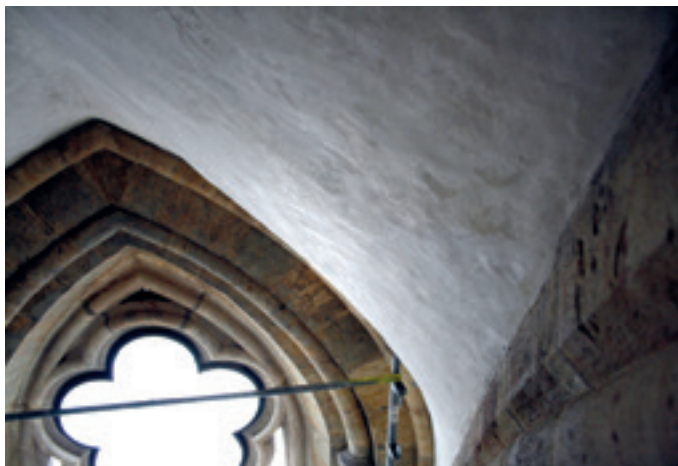
Obr. 2. A, B. Praha 1-Staré Anežský klášter, kostel sv. Salvátora. Pohled na skládanou kápi klenebního pole v polygonálním závěru (foto M. Patrný, 2007).
