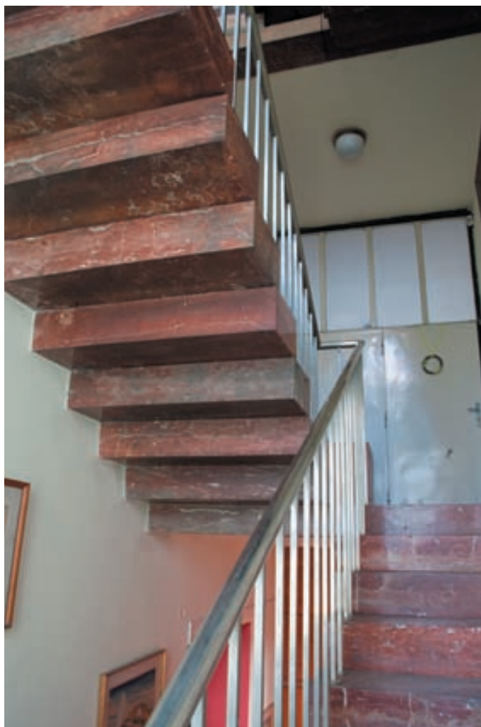
Obr. 16. Praha 6-Střešovice, čp. 711, Kodlova vila, Patočkova 5, Nad Vojenským hřbitovem 4, Na Hubálce 12. Pohled na interiérové schodiště s mramorovými stupni a nerezovým zábradlím (foto P. Havlík, 2010).
