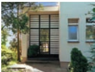
Obr. 5. Praha 6-Střešovice, čp. 820, Na Bateriích 13. Pohled na vilu z ulice Pod Andělkou (foto A. Křížová, 2011).
