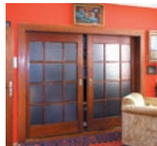
Obr. 17. Praha 6-Střešovice, čp. 711, Kodlova vila, Patočkova 5, Nad Vojenským hřbitovem 4, Na Hubálce 12. Pohled na dělicí posuvné dveře mezi místností jídelny a knihovny (foto A. Křížová, 2004).
