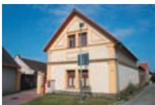
Obr. 38. Praha 22-Kolovraty, míst. č. Tehovičky, čp. 115, V Tehovičkách 5 (foto L. Vatr, 2009).
