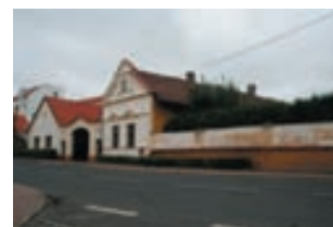
Obr. 32. Praha 22-Kolovraty, míst. č. Tehovičky, čp. 107 a čp. 414, Mírová 31. Vlevo bývalý čeledník (foto L. Valtr, 2009).
