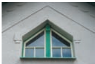
Obr. 6. Praha 22-Kolovraty, čp. 1, Mírová 74. Pětiúhelníkové okno v horní části uličního štítu (foto L. Valtr 2007).
