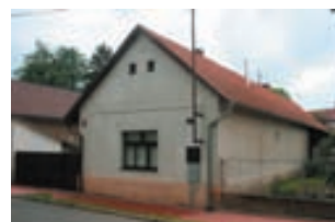
Obr. 22. Praha 22-Kolovraty, čp. 68, K Jezu 8 (foto L. Valtr 2007).
