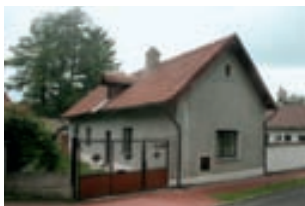
Obr. 25. Praha 22-Kolovraty, čp. 77, K Jezu 12 (foto L. Valtr 2007).
