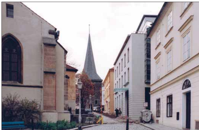
Čp. 536 na místě původního čp. 1431 – novostavba u sv. Štěpána (foto I. Russová).
